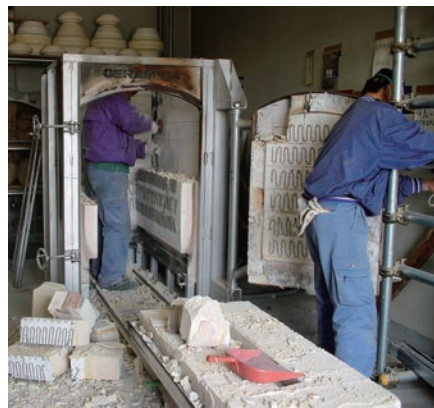
既設電気炉解体
